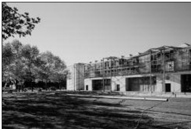
ENSA de Lyon - Façade est - Photo Jean-Marie Monthiers ©
