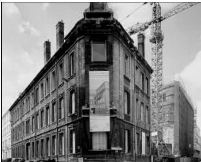
ENSA de Saint-Etienne - Pignon de la façade sud-est vue de la place Jacquard avant travaux - Photo Jean-Marie Monthiers o
