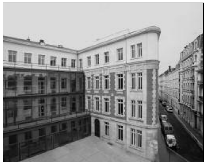
L'ENSA vue de la rue Buisson après rénovation - Pignon de la façade sud-est vue de la place Jacquard avant travaux - Photo Christophe Camus o
