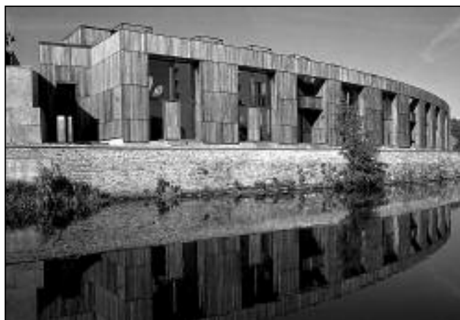
ENSA de Bretagne en bordure du canal d'Ille-et-Rance
