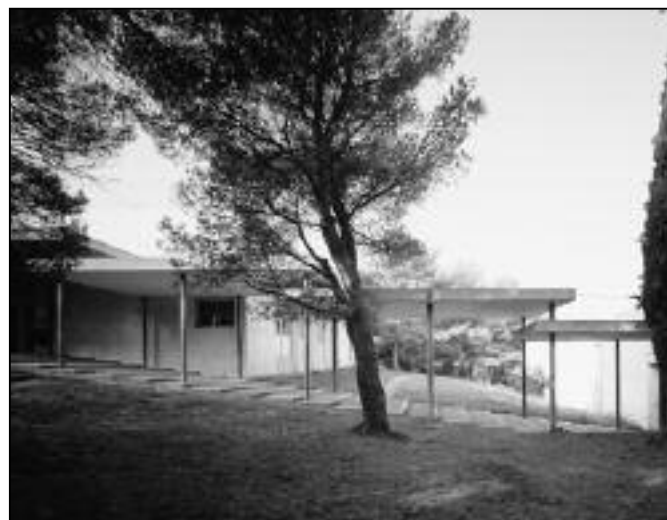
ENSA de Marseille - Galerie couverte entre 2 corps de bâtiment - Photo Jean-Marie Monthiers ©
