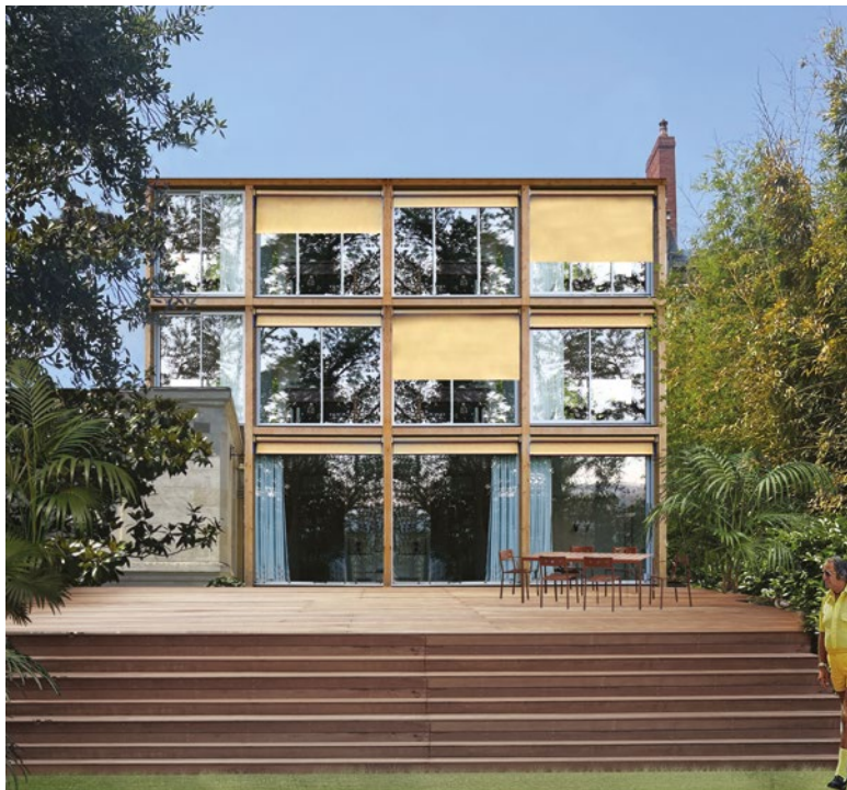
↘Extension maison, Bordeaux, 2023
