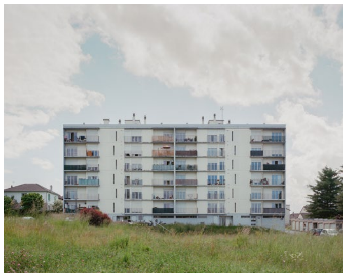
↘Photographie de l'existant de la résidence GANET à Brive-la-Gaillarde (19), 870K€HT, Projet de réhabilitation, MOA : Brive Habitat, ©Charles Bouchaïb
