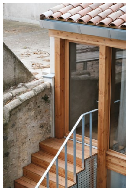
↳Usclas (34) Construction d'une annexe, structure bois - Détail de façade
