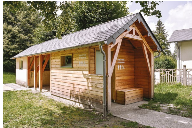
↘ Commune de Lacelle (19), projet public, extension d'une bascule, création d'un préau et de sanitaires publics, projet réceptionné en février 2023
