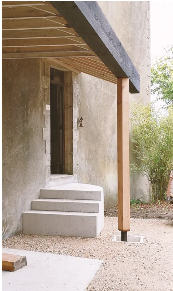
↘Ourtiquet – Transformation d'une grange en habitation et extension en ossature bois à Salles-Curan (12)
