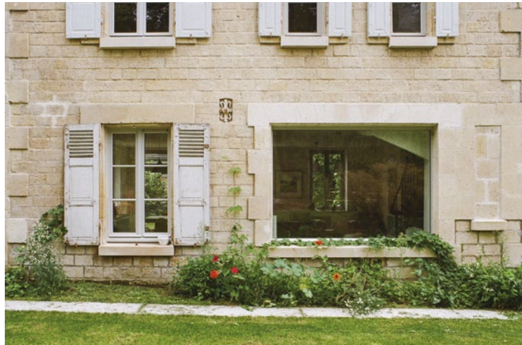
↳ Rénovation lourde d'une longère à l'abandon - la façade, MOA privée, Aisne (02), livré 2022 @Camillacardia
