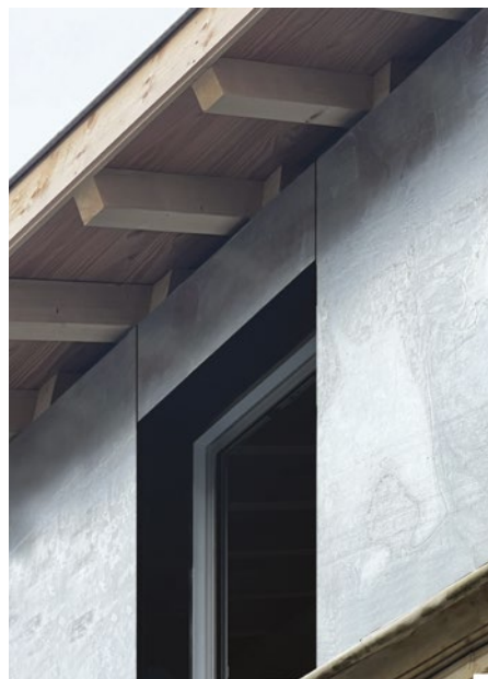
↘Surélévation ossature bois, Bordeaux, 2022
