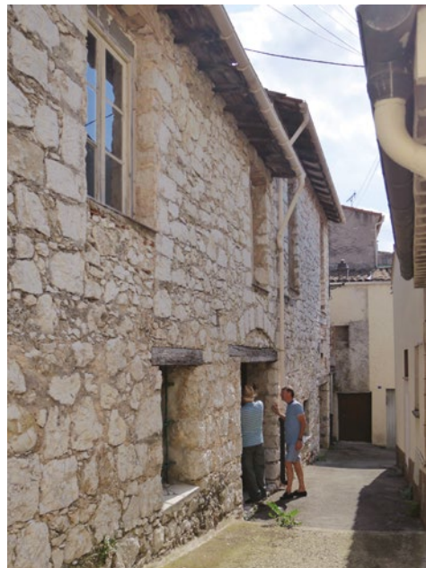
↳ Bouyon | Transformation d'un atelier de menuiserie en atelier-logement flexible pour un collectionneur de voiture | mission conception | Bouyon (06)
