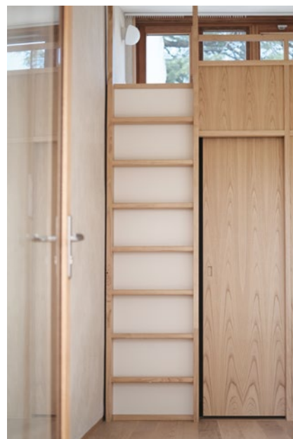
↳Usclas (34) Construction d'une annexe, structure bois - Enduit terre et menuiserie en châtaignier
