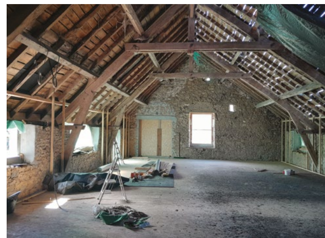
↘ Bretagnolle, commune de Pierrefitte (19), Réhabilitation d'une longère corrézienne en habitation + espace d'entraînement circassien, projet privé, chantier en cours
