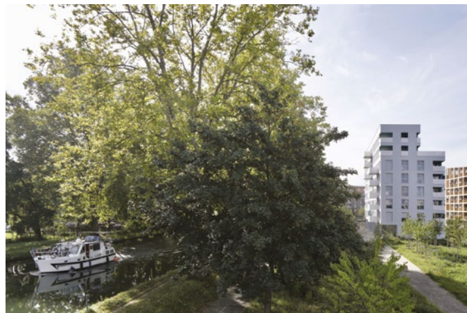
↘ Construction de 39 logements en accession sociale à Illkirch-Graffenstaden – 67 (en association avec LDA)
