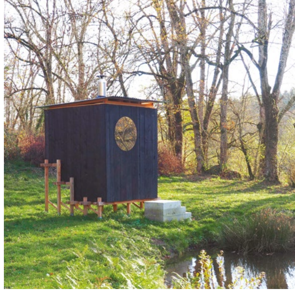
↘Le sauna – Réalisation d'un sauna en auto-construction (chantier participatif) à Pont-de-Salars (12)
