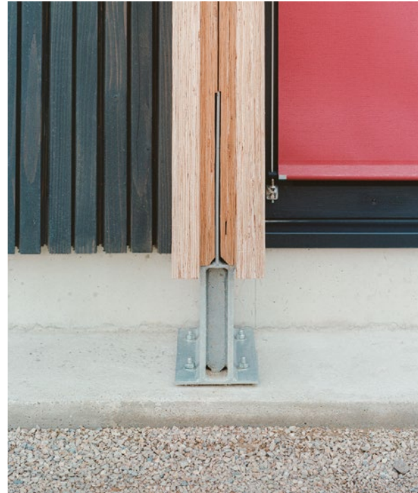
↘Projet de bureaux à Brive-la-Gaillarde (19), 420K€HT, MOA : professionnel, ©Charles Bouchaïb
