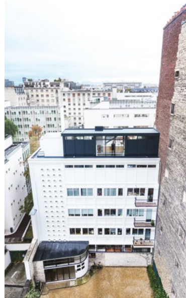
↳ Surélévation d'un immeuble de logements des années 1950 à Paris (75)
