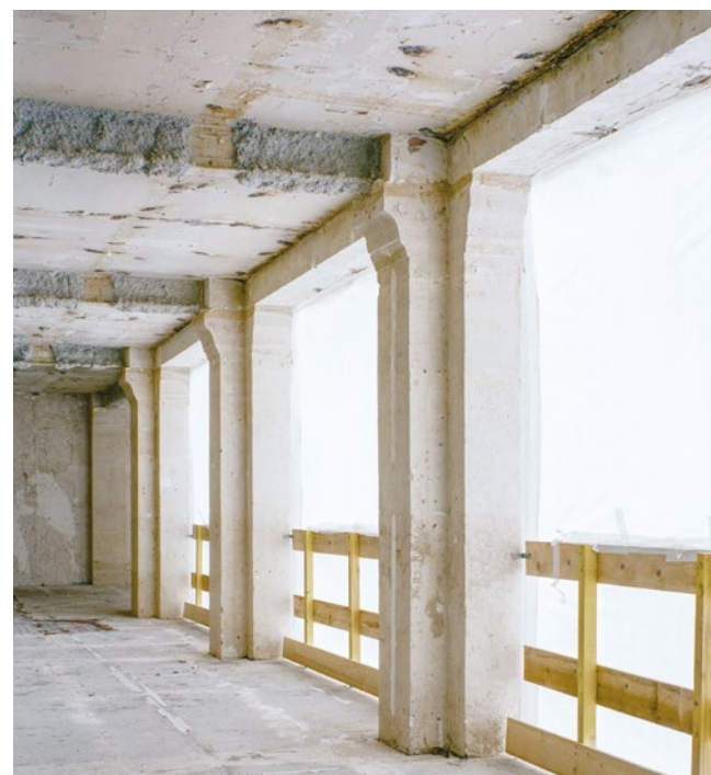
↳ Restructuration d'anciens ateliers de confection de tissus en bureaux à Paris (75)
