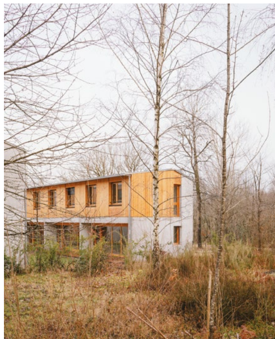
↳ Construction d'un village SOSVE - Fontcouverte (17)
