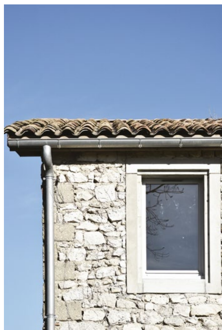
➤ Nouvelles baies créées pour éclairer les chambres de l'étage. Détail du tableau en béton préfabriqué et menuiserie en bois peint.
