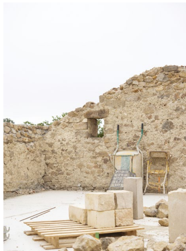
↳ Rénovation lourde d'un corps de ferme à l'abandon - Chantier lot gros œuvre, MOA privée, Aveyron (12), chantier en cours
