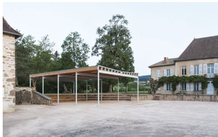
↳ Construction d'une halle et aménagement d'un parvis, Matour (71), livré (2023), MOA publique, ©Vincent Boutin
