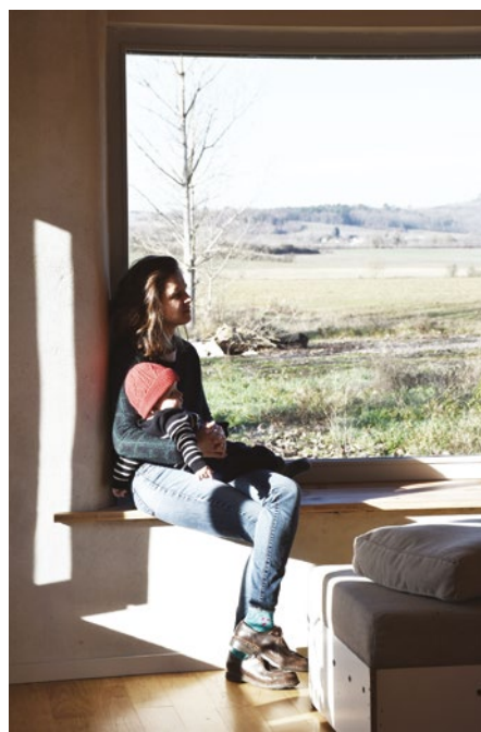
➤ Vue sur le grand paysage depuis la baie du salon. Allège-assise en épicea. Mur en chaux chanvre banché finition chaux-sable. Parquet châtaignier du Périgord clouté sur lambourdes chênes.
