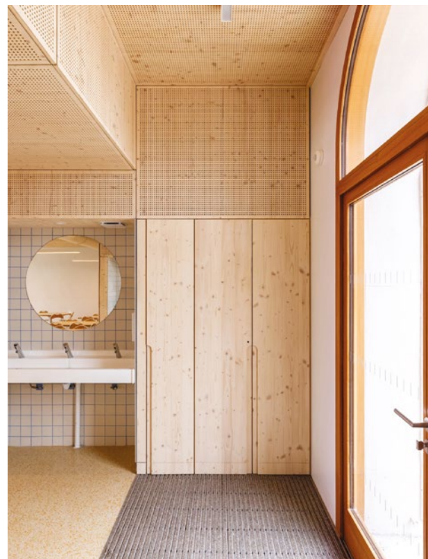
↳ Réhabilitation et extension d'un restaurant scolaire, Crissey (71), livré (2022), MOA publique, ©Vincent Del Valle
