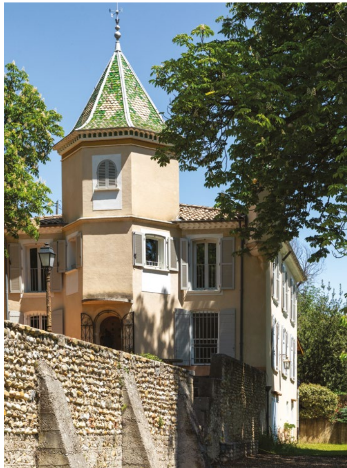
↘Rénovation d'une maison de maître à Valensole dénaturé par des rénovations successives. Agrandissement des ouvertures au 1 er niveau, remplacement des fenêtres en PVC par du bois, réfection des encadrements
