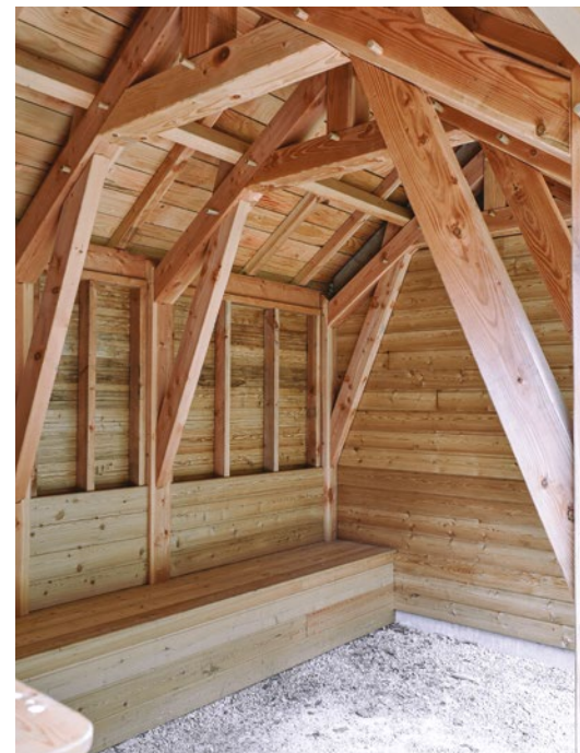
↘ Commune de Lacelle (19), projet public, extension d'une bascule, création d'un préau et de sanitaires publics, détail de la charpente projet réceptionné en février 2023
