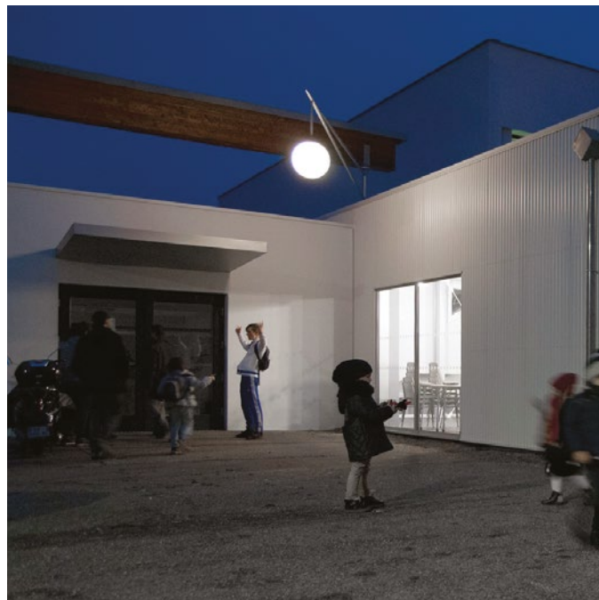
↘ Construction d'un club-house adossé à un gymnase à Hoenheim – 67
