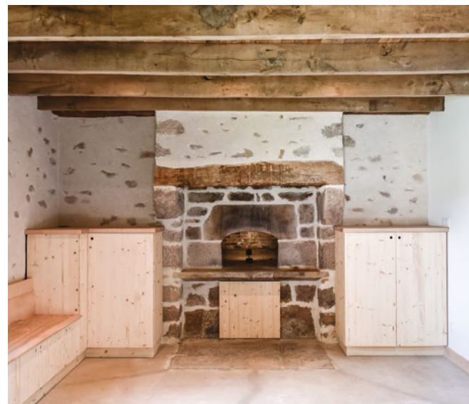
↘ Projet au sein des locaux du Parc Naturel Régional du Plateau de Millevaches (19), projet public, réhabilitation d'un fournil en espace multimédia, projet réceptionné en juin 2023
