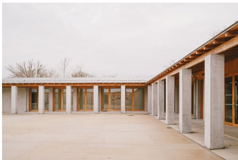
↳ Construction d'un village SOSVE - Fontcouverte (17)
