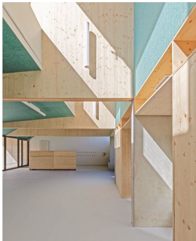
↳ Construction d'un restaurant scolaire, Demigny (71), en cours de livraison, MOA publique, ©Vincent Boutin
