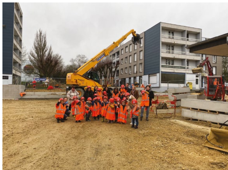
↳ Visite de chantier de la place de la commune au Bourny avec les enfants de l'école Marcel Pagnol (53) #villeàhauteurdenfants #chantier #placepublique
