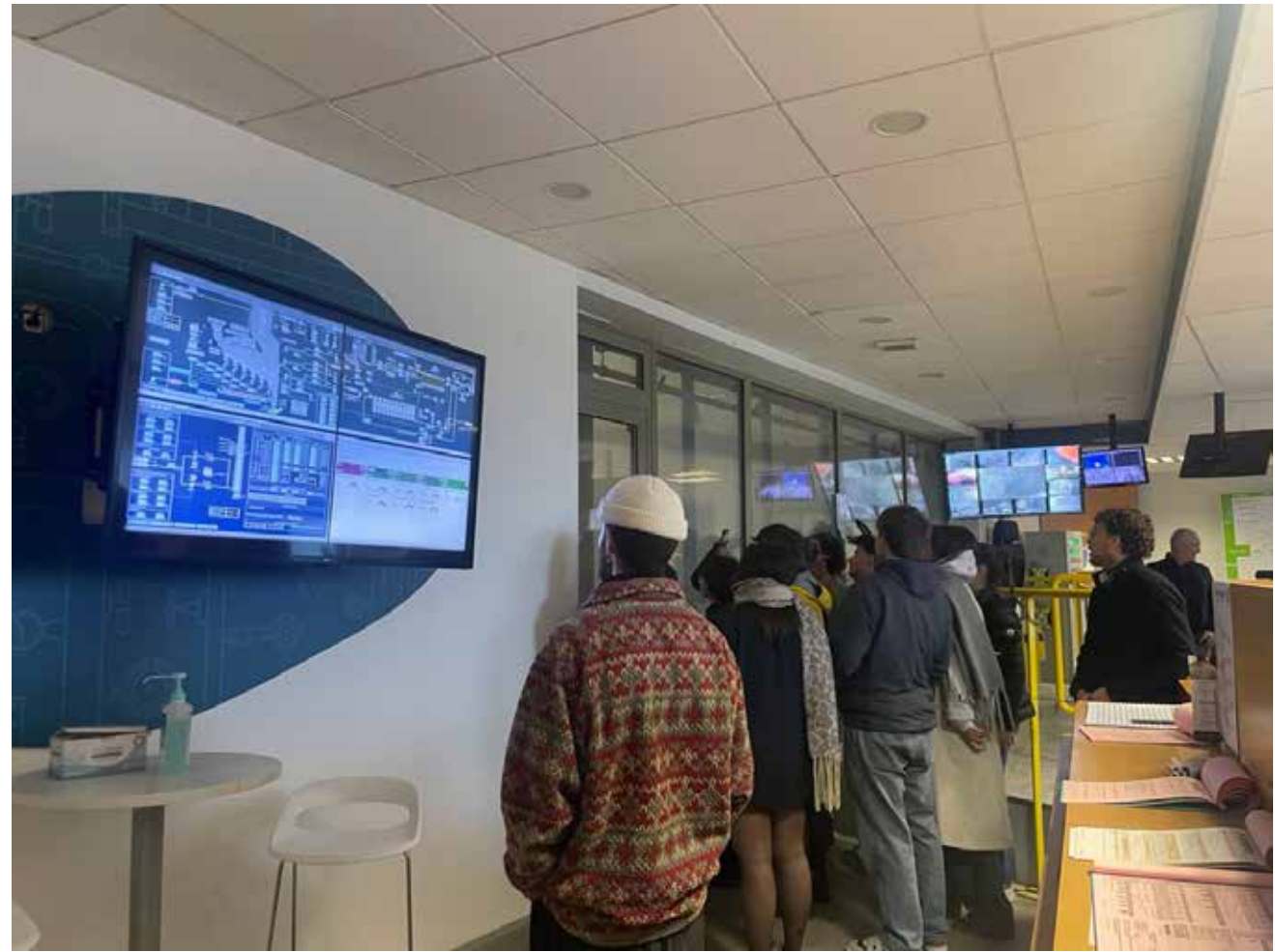
Visite de l'incinérateur de Clermont-Ferrand dans le cadre du séminaire "Maintenance"
