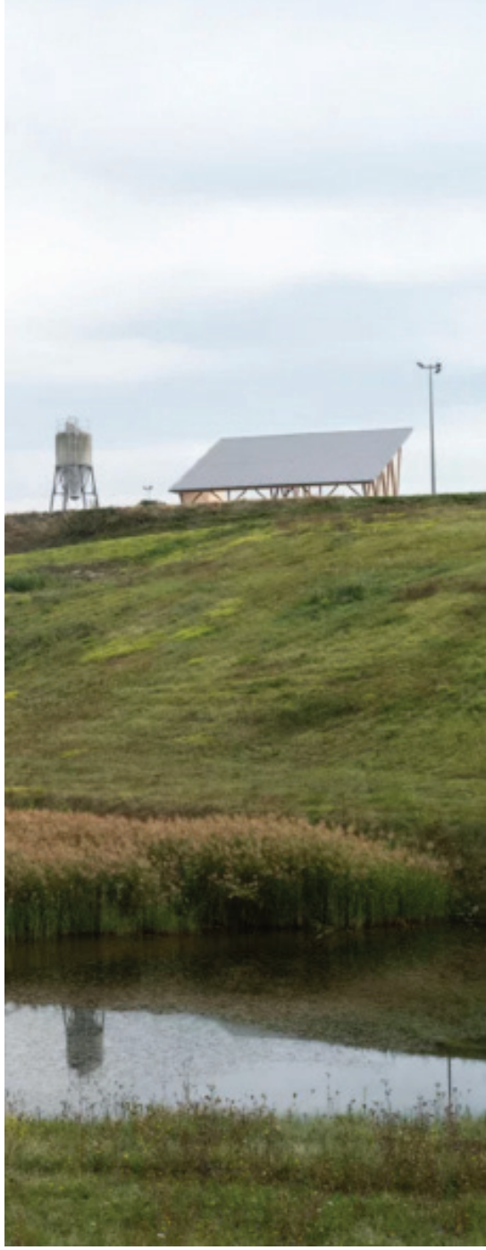
Photographie de Atmosphériques Narratives d'un des 6 Hangars de stockage à sel réalisé par Sapiens architectes. 2020.
